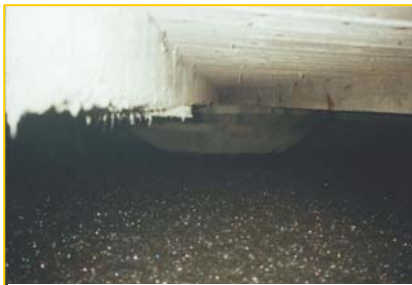
Figuur: biologische ontzwaveling boven een staande vergister
