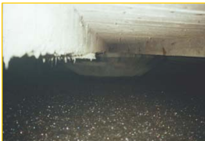
Figuur: biologische ontzwaveling boven een staande vergister
