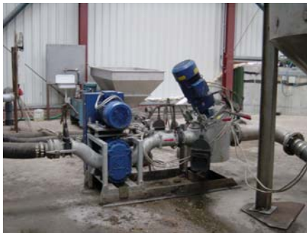
Figuur: Pomptechniek(incl. steen/gruis afvanger)
