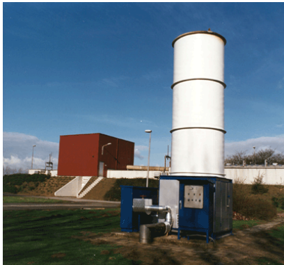
Figuur: gesloten affakel installatie
