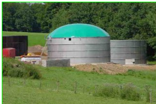
Figuur: vergister met gasbuffer
