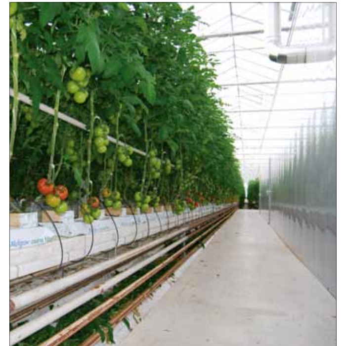
Trostomaten, met boven de teelt en daaronder de buizen van het verwarmingssysteem
