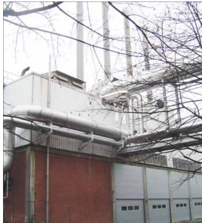
De energiecentrale van Agfa
