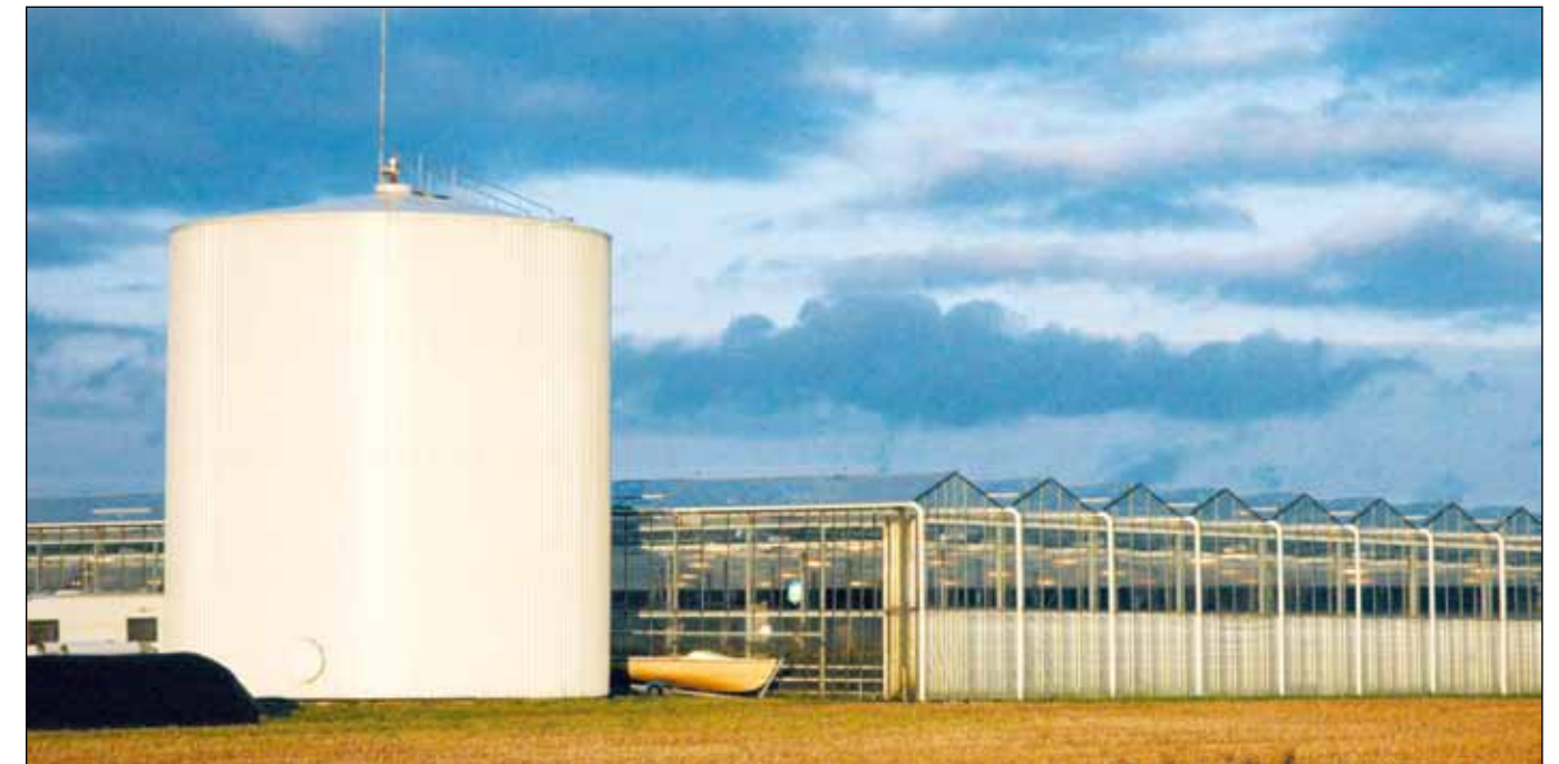
Opslagtank voor buffering bij een tuinder
