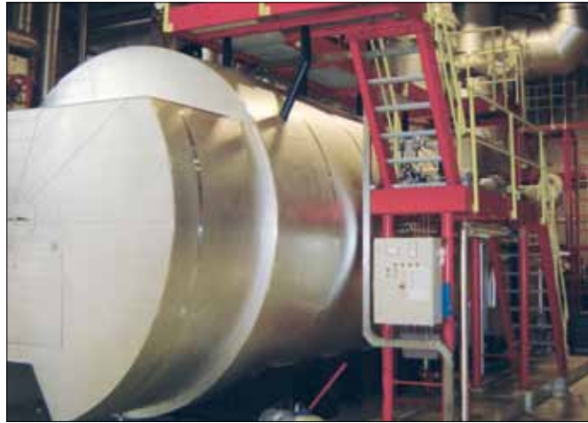
De afgassenketel (maximaal 20 ton/h)
