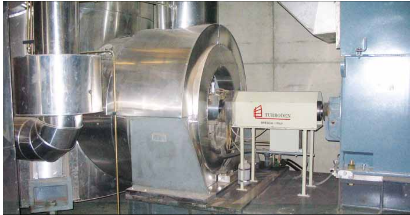
ORC gevoed met rookgassen (Turboden)
