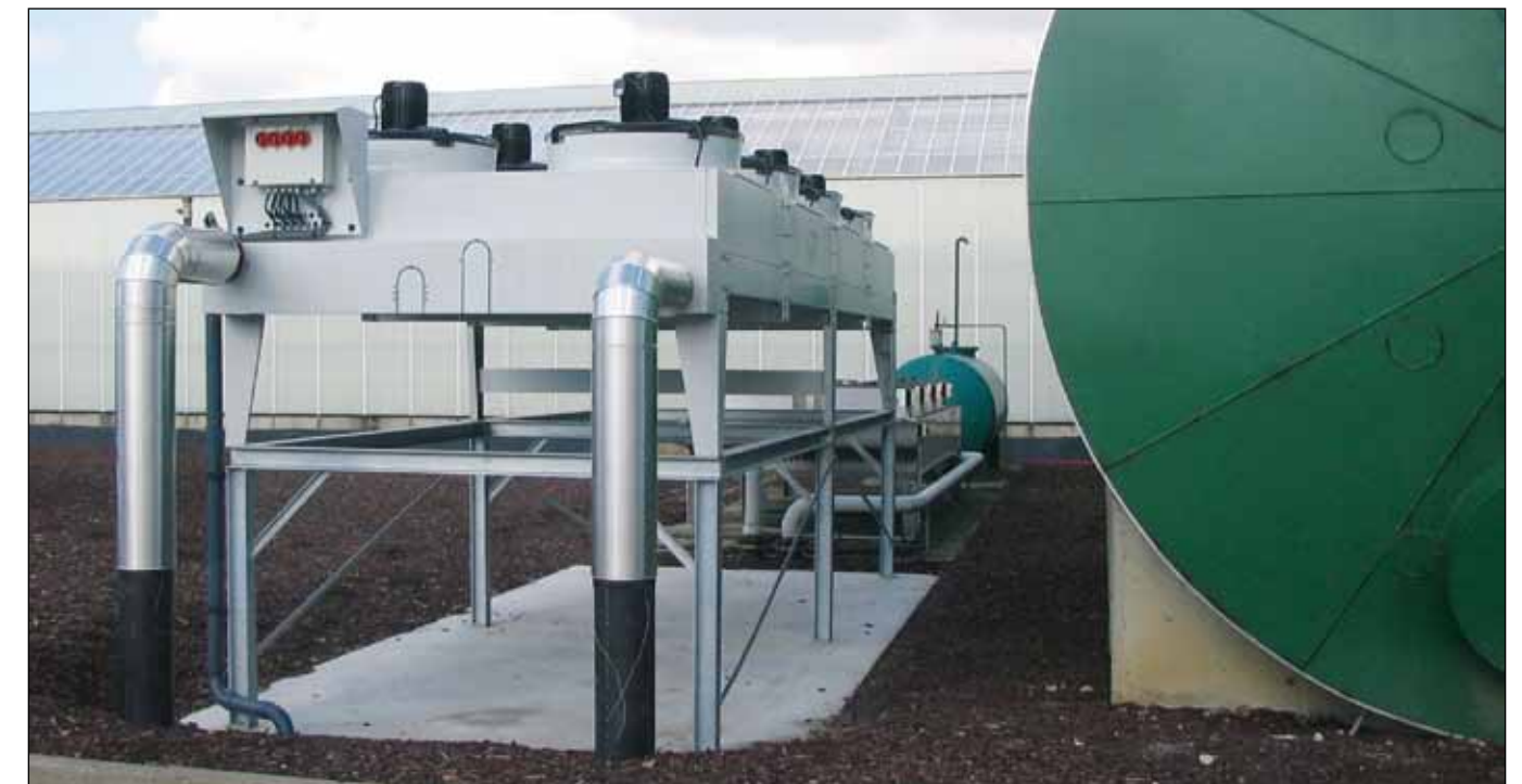
Een tafelkoeler naast een warmtebuffer
