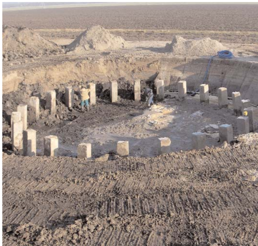
Investeren in wind vereist een goede grondslag Fundering van een 3 MW windmolen
