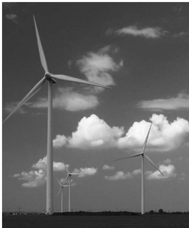
Zagórze wind farm @PWEA
