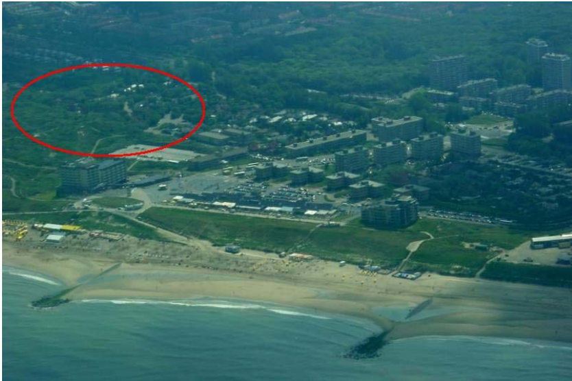
Figuur 3-6 Kijkduin, Den Haag. De gesimuleerde wijk ligt in de rode cirkel, buiten het centrum
