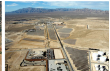
Las Vegas, US - Nellis AFB 14.2 MW SunPower T20 Tracker
