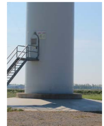
Afbeelding 4: grote windturbine met rustige inrichting op maaiveld.
