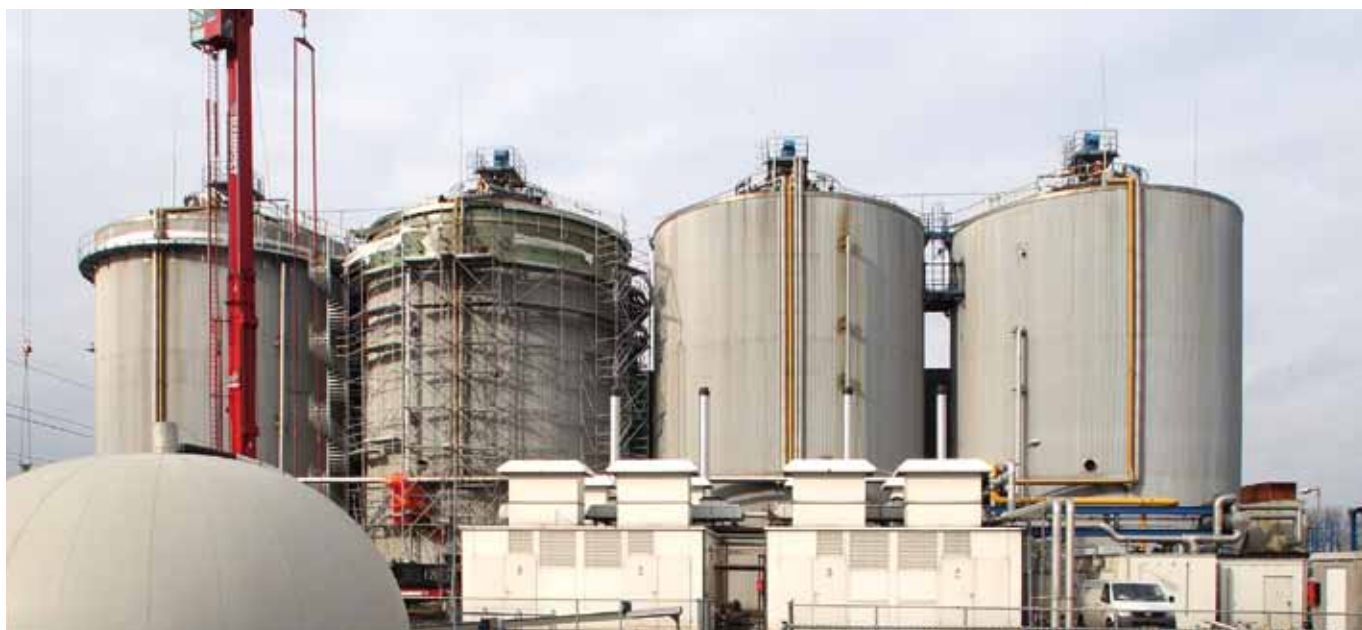
Afvalscheidingsfabriek en vergistingsinstallatie aan het Winschoterdiep
