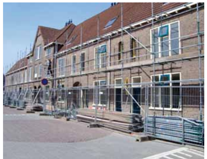
Renovatie De Hoogte
