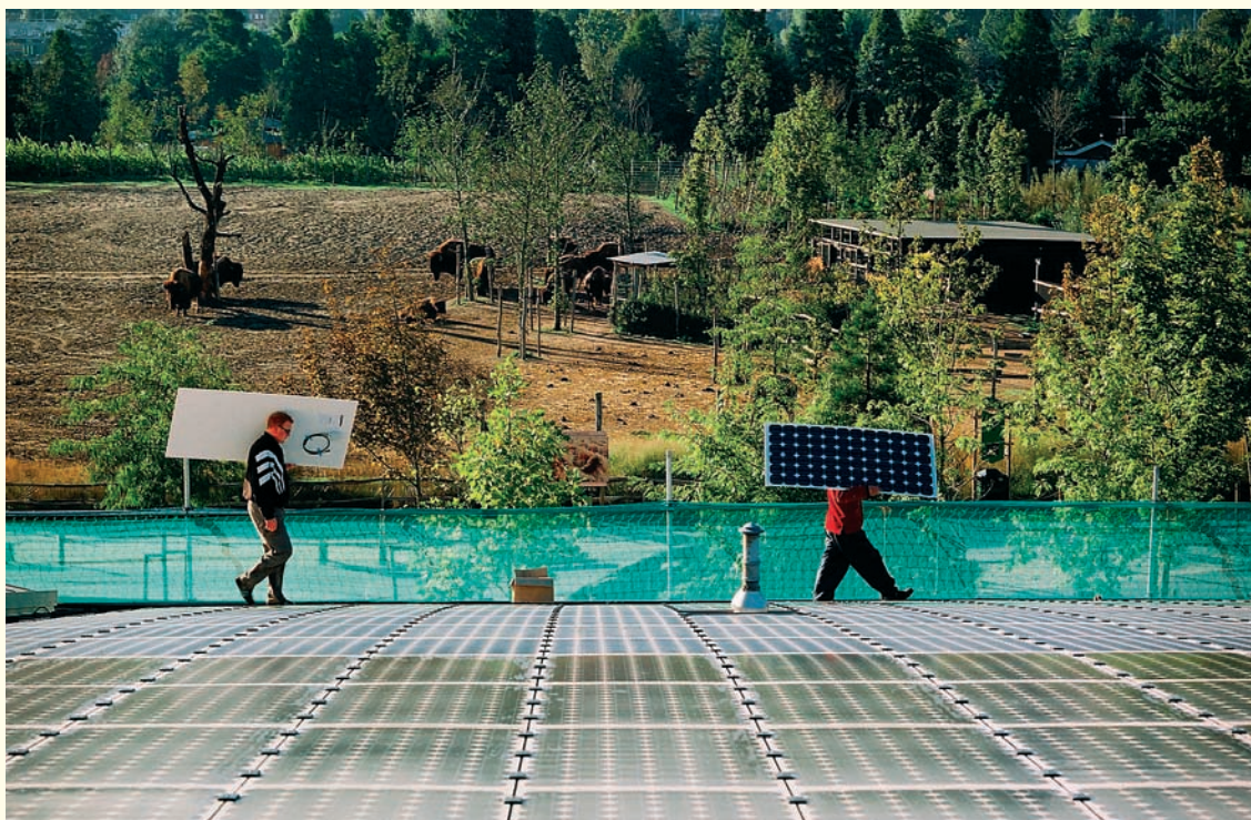
500 kWp-systeem op dak van Oceanium, Diergaarde Blijdorp. (foto Siemens)
