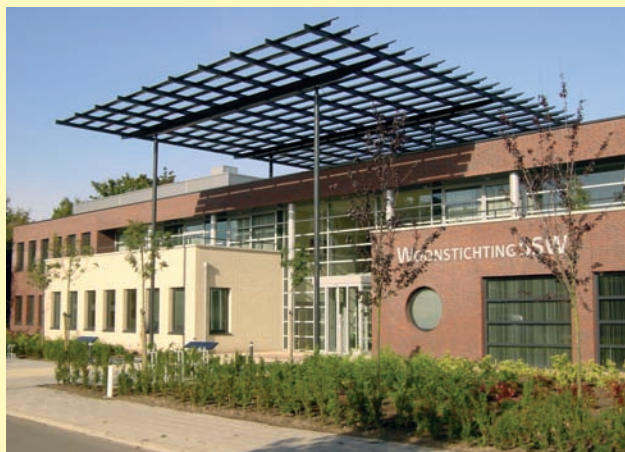
Zonnesherm met 25 kWp CIGS-systeem.
