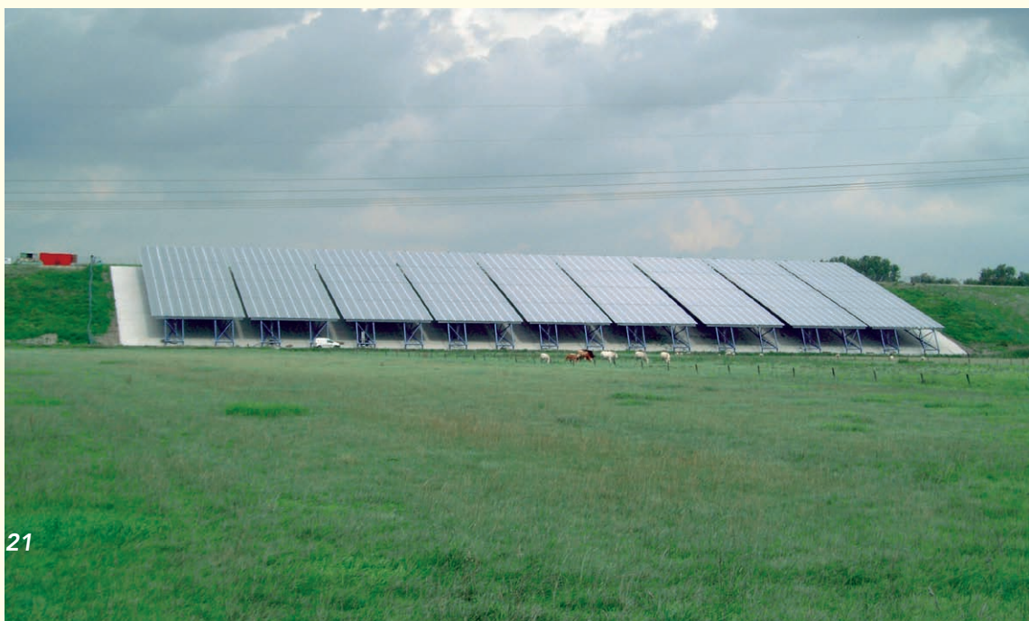
Zonnestroomcentrale in Waalwijk, Nederland, 0,7 MWp (foto: Shell Solar)
