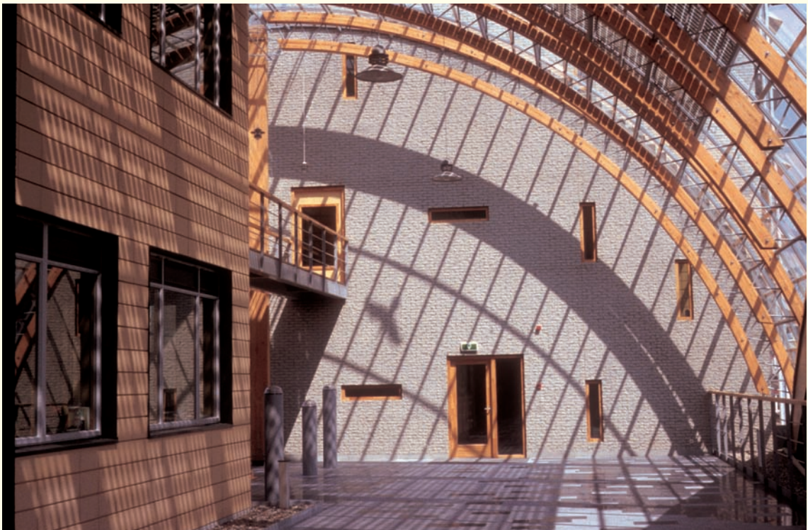
Combinatie van functies: opwekking zonnestroom en zonwering in het dak van een kantoorgebouw bij ECN in Petten. (foto BEAR Architecten)
