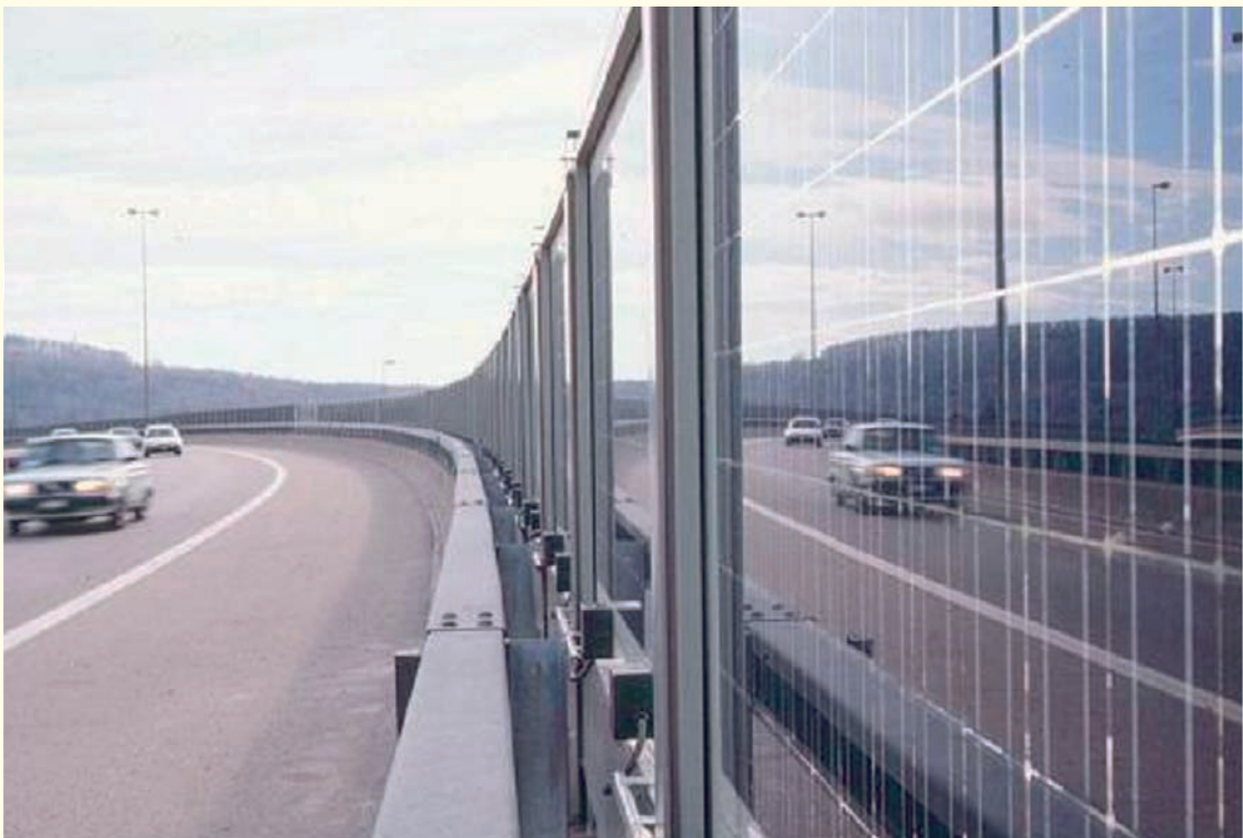
Dubbelzijdig werkend zonnestroomsysteemgeïntegreerd in een geluidswal. (foto TNC Consulting, CH)
