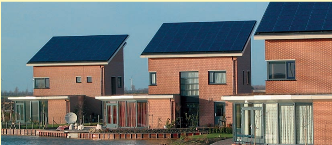
Woningen met 5 kWp dakgeïntegreerde zonnestroomsysteem in Langedijk. (foto ECN)
